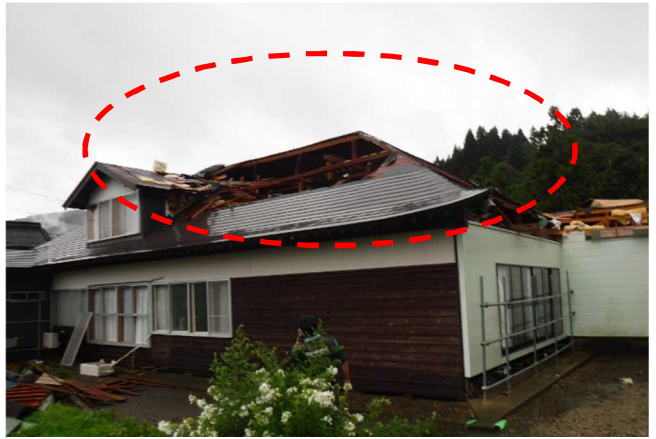
屋根が北東へ飛散した木造住宅(東から撮影)
