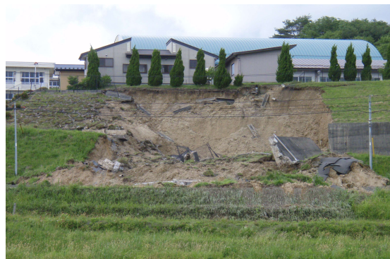
写真2. 栗原市鶯沢の法面崩落
