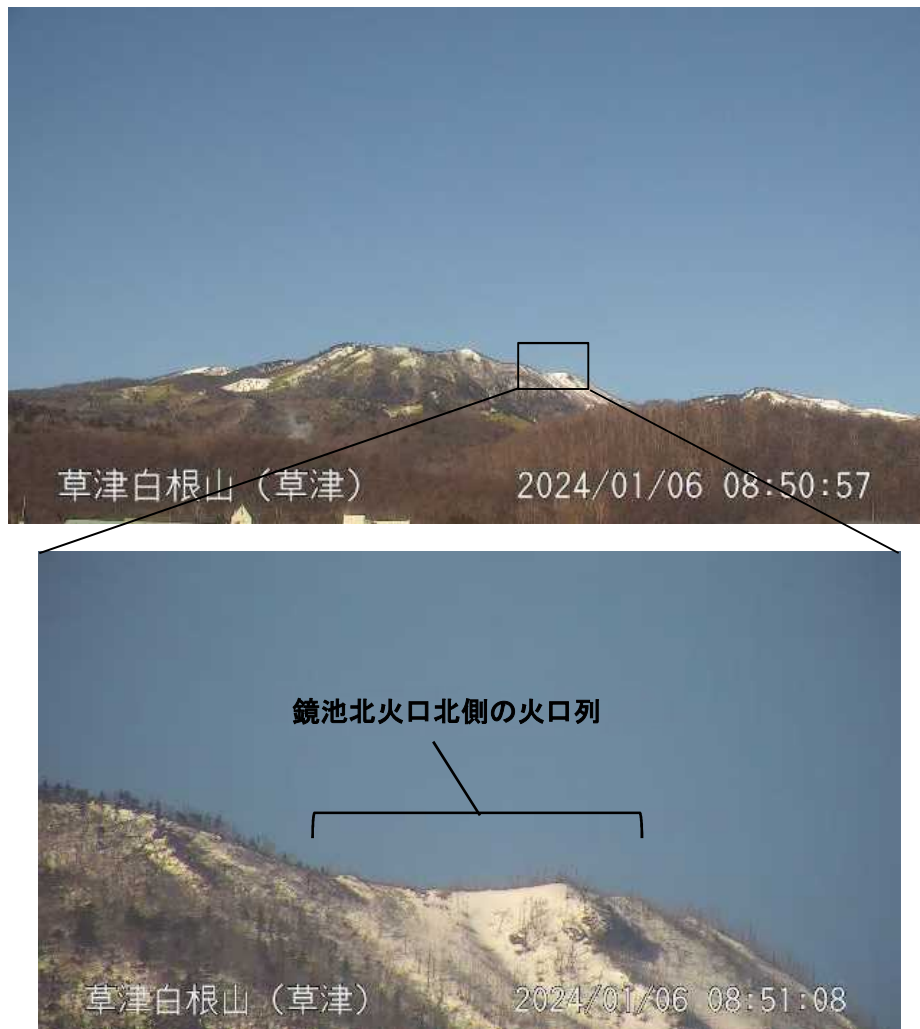
図12 草津白根山（本白根山） 本白根山付近の状況（草津監視カメラ）
