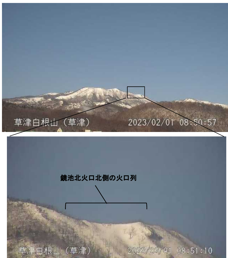
図8 草津白根山（本白根山） 本白根山付近の状況（草津監視カメラ）
