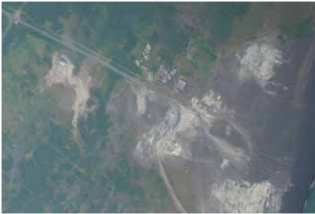
阿蘇台陥没口
