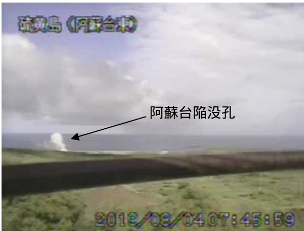
阿蘇台陥没孔の噴気の状況（8月4日撮影）
