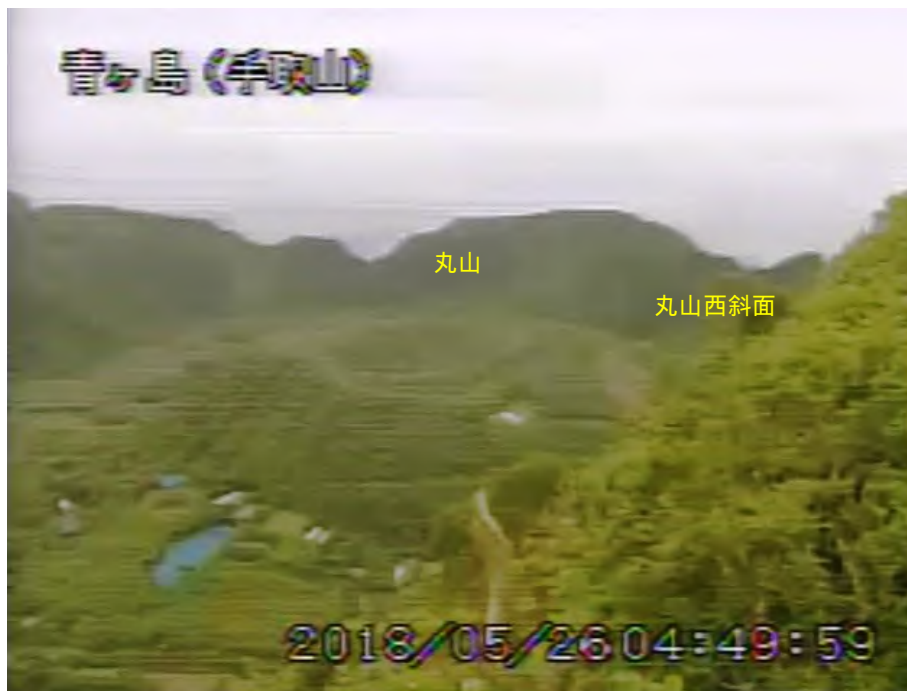
図 1 青ヶ島 丸山西斜面の状況（5 月 26 日 手取山監視カメラによる）
