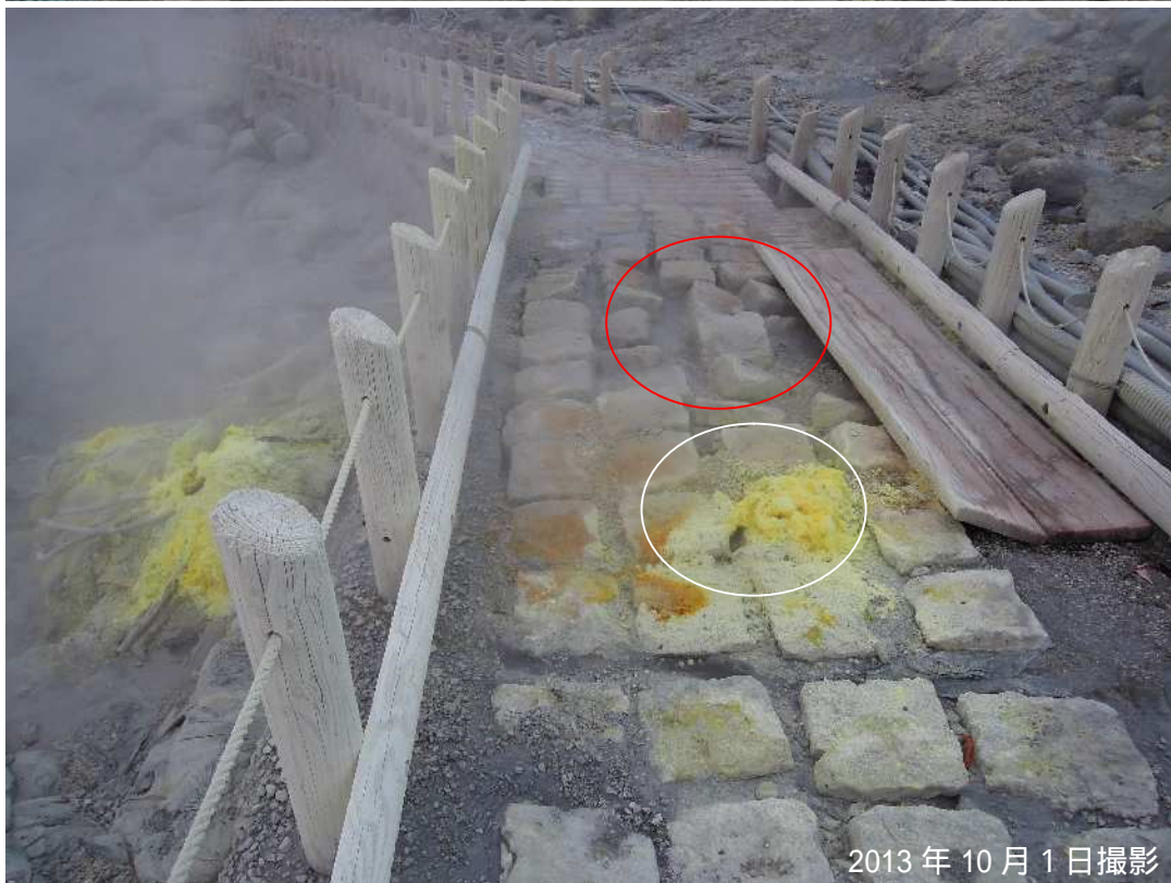
図5 弥陀ヶ原 地獄谷遊歩道の状況
