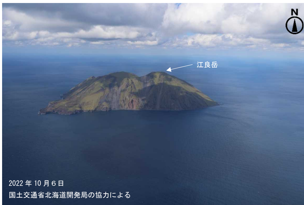
図2 渡島大島 島全体の状況 南側上空（図1の①）から撮影
