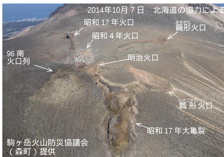
図4 北海道駒ヶ岳 山頂火口原の状況 南側上空(図3 - の矢印方向)から撮影
