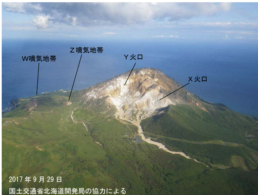
図 3 恵山 火口周辺の状況 北西側上空（図 2 の①）から撮影
