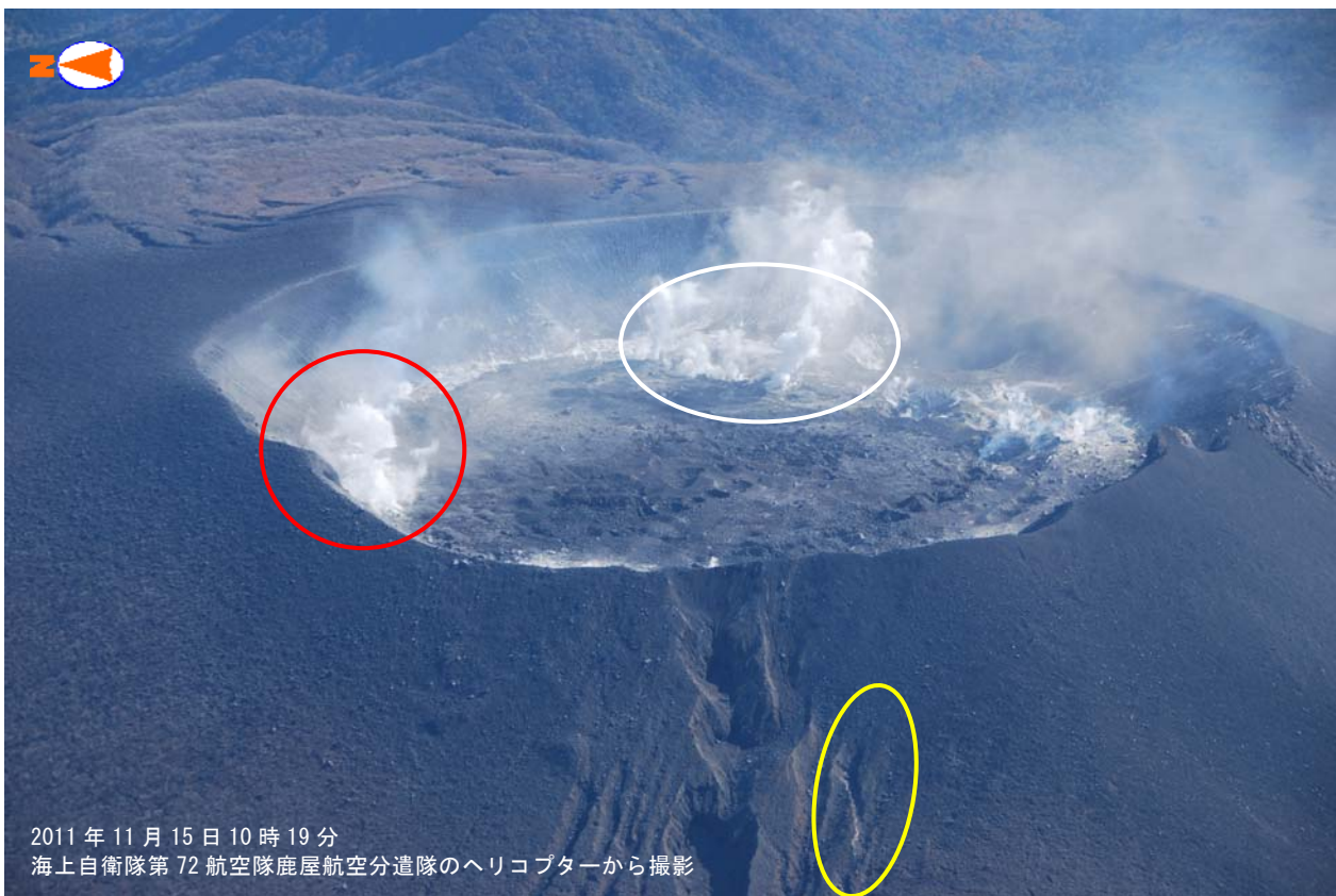
図1 霧島山（新燃岳） 火口内の状況
