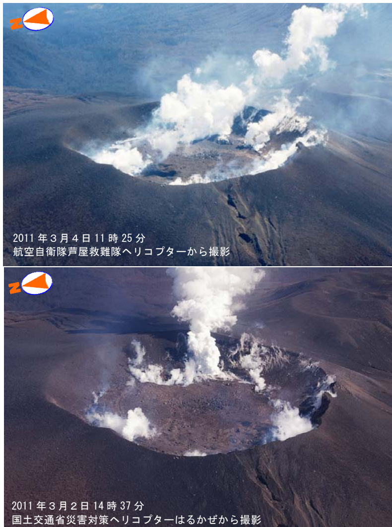
図 1 霧島山（新燃岳） 火口内の状況
