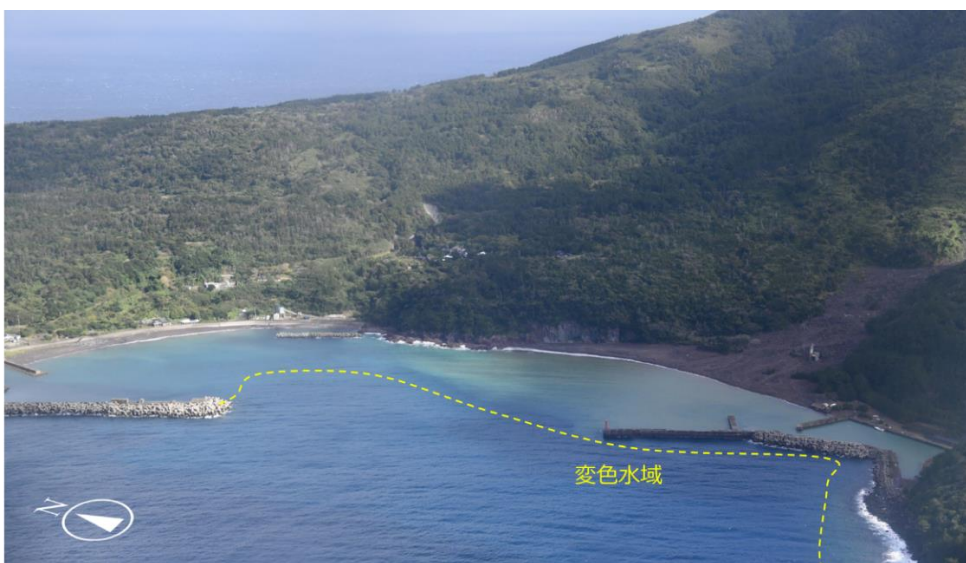
第 6 図 口永良部島 口永良部漁港 2023 年 12 月 21 日 12:10 撮影
