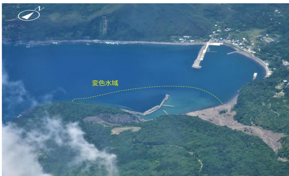
第 6 図 口永良部島 口永良部漁港 2023 年 5 月 10 日 11:48 撮影
