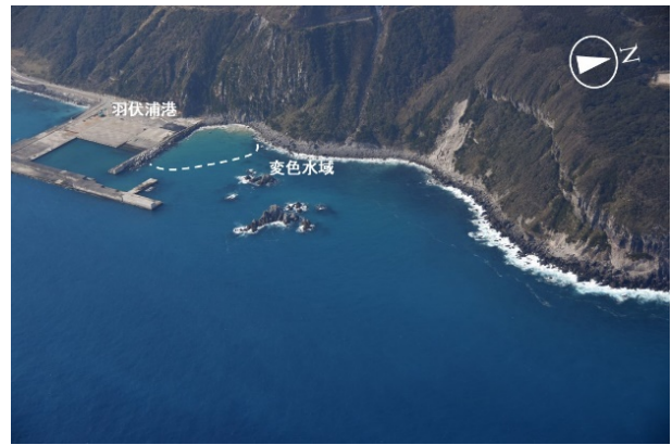
第5図 新島 羽伏浦港の変色水域
