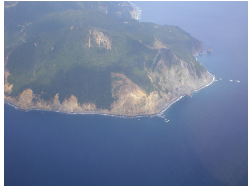
写真35 口之島 Photo.35 Kuchinoshima
