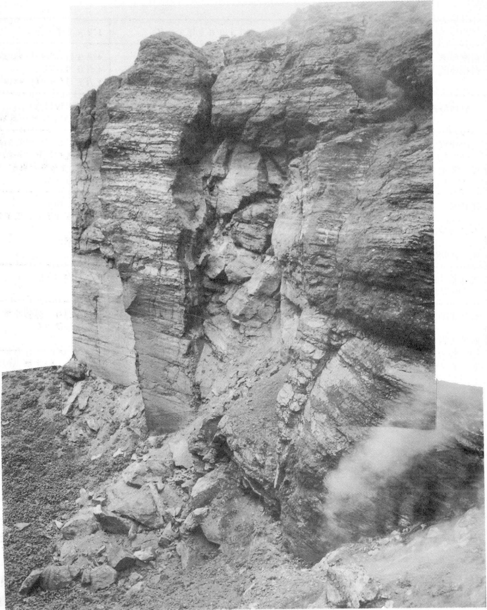
第 19 図 北海道南西沖地震の震動で崩壊した北海道駒ヶ岳の 1942 年火口壁
