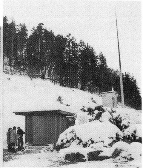
第 2 図 噴火予知計画に基づく北海道大学理学部の雌阿寒岳の火山観測研究施設（平成 4 年 2 月竣工）。右図；雌阿寒岳野中温泉送信所（空振計，テレメータ機器設置，左手前前），左図；地震観測井（38 m 深，1 Hz 3 成分地震計，手前のマンホール），及び地表加速度計，傾斜計，増幅器類（奥のマンホール）。右図奥のアンテナ付きの小屋は，北海道開発局の雨量テレメータ。
