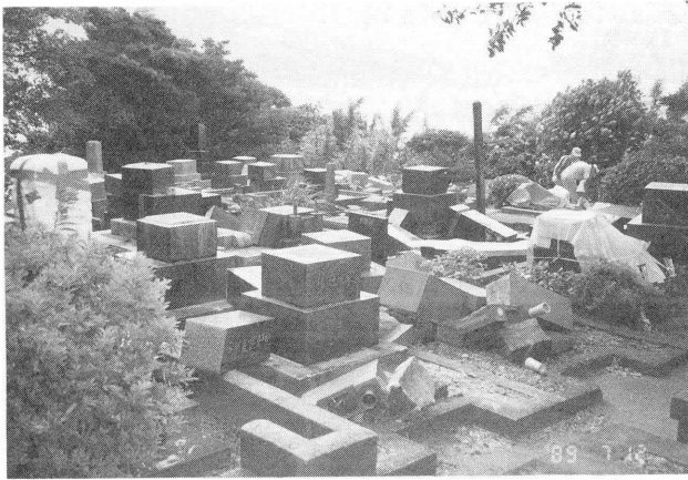
写真3 転倒した墓石 墓石総数220~230中, 90%の墓石が転倒。転 倒方向は東西方向であった。(宝専寺, 伊東市新 井2-10-3, 7月12日静岡地方気象台撮影)
