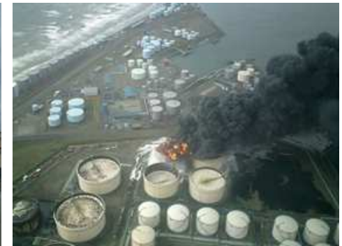
平成15年十勝沖地震による石油タンクの被害
