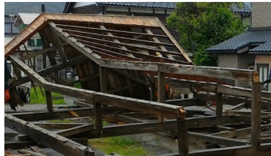
写真4 駐輪場の倒壊
