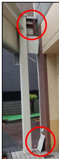
写真8 看板の破損
