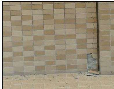
写真10 アパート外壁のひび割れ・剥離
