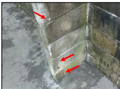
写真9 ブロック塀のひび割れ
