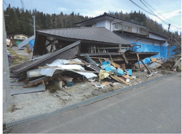
写真 4 家屋の倒壊（白馬村神城堀之内）
