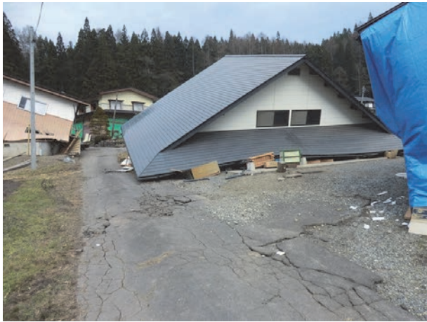
写真 5 家屋の倒壊（白馬村神城堀之内）
