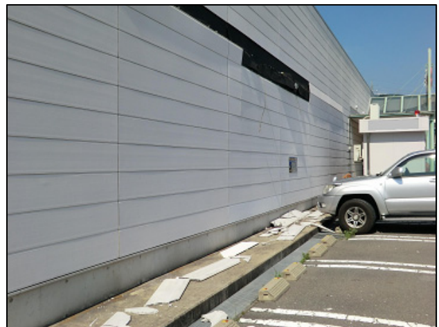
外壁の一部破損（松本市寿付近）
