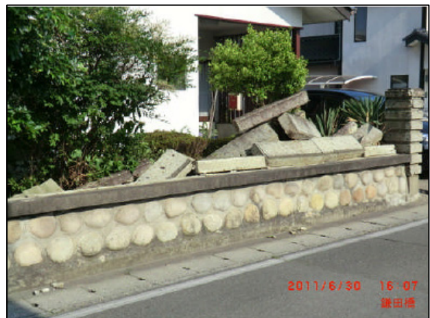
ブロック塀の倒壊（松本市鎌田付近）
