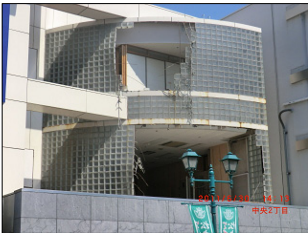
ガラスの破損（松本市役所付近）
