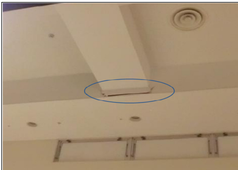
建物（ショッピングセンター）の内壁ひび割れ（新潟県十日町市上山）
