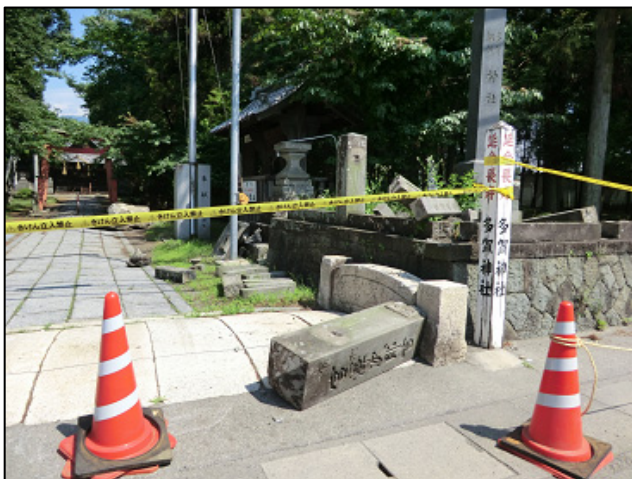
石柱の倒壊（松本市出川付近）
