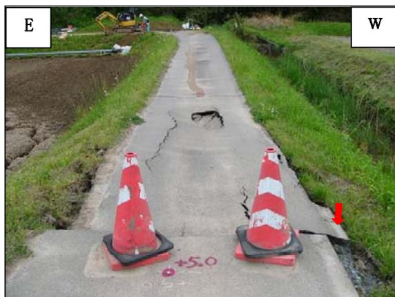
写真 9 道路に亀裂が生じ、西側へずれがみられる
