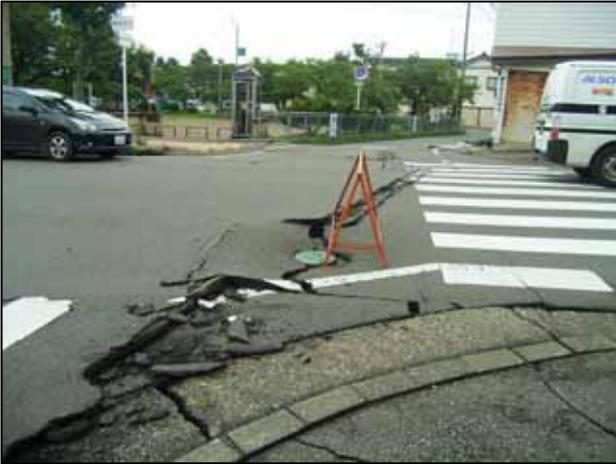
写真 5 道路の陥没によるアスファルトの亀裂
