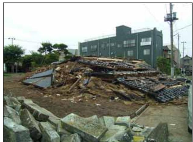
写真 4 崩壊した木造の瓦屋根の家（中央）
