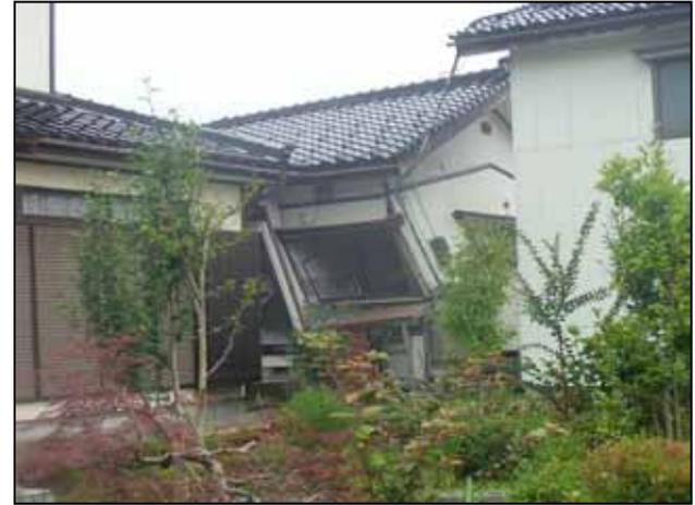
写真 10 倒壊した木造の屋根瓦の家
