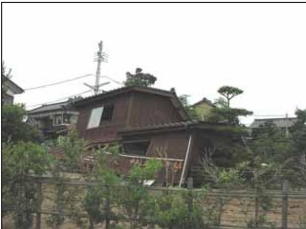
写真 7 倒壊した木造の瓦屋根の家
