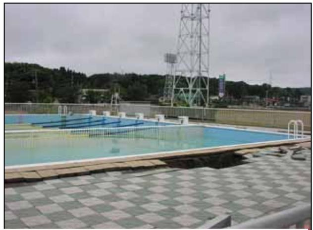
写真 8 プールサイドの陥没
