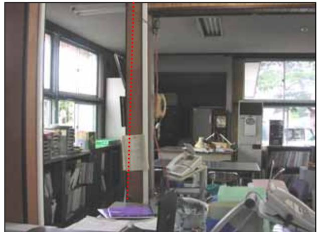
写真 14 飯綱町役場三水庁舎内の傾いた柱
