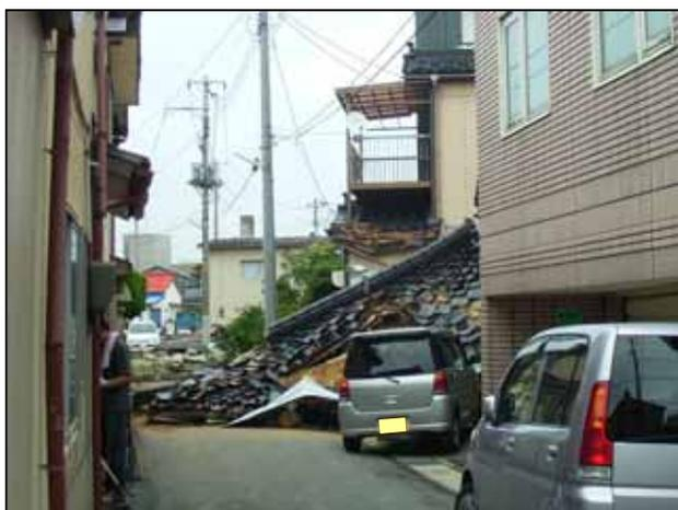
写真 3 崩壊した木造の瓦屋根の家
