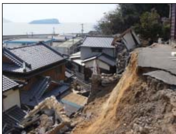
写真 10 . がけ崩れにより損壊した道路
