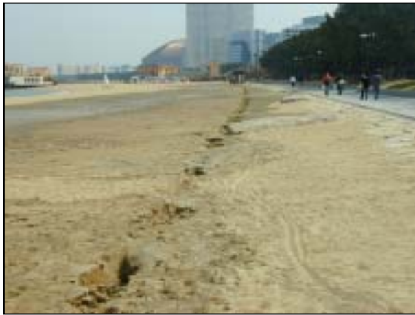
写真 14 .液状化により約 100m 以上に渡り亀裂が生じた砂浜
