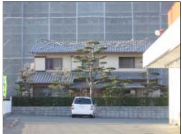
写真 17．瓦の一部が破損した家屋
