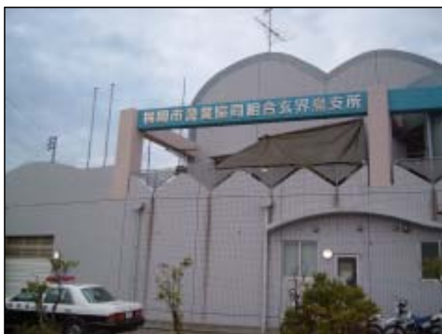
写真 6 . 被害が見られなかった海岸近くの新しいＲＣ建物（現地本部が置かれている）
