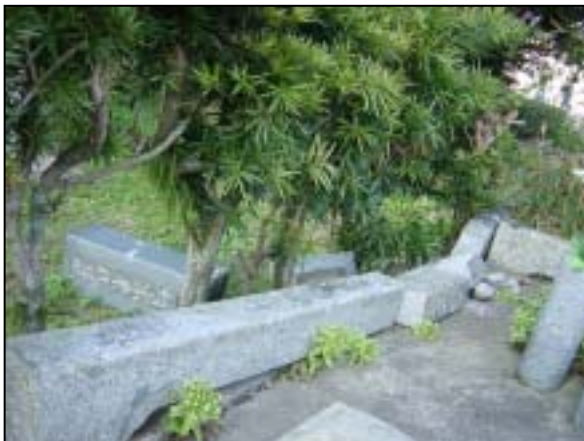
写真 16．大きく倒壊した墓石
