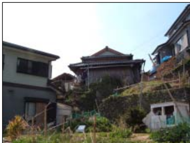
写真 8 . がけ崩れにより損壊した家屋
