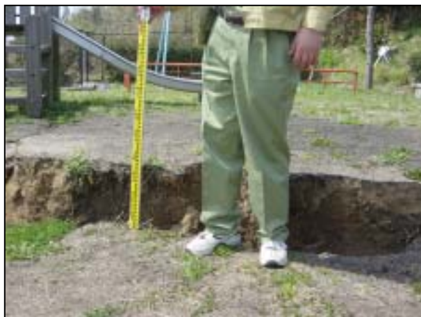
写真 7 . 島上部の小学校近くの公園の亀裂 （約 40cm の段差）
