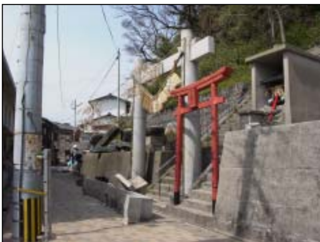
写真3 . 鳥居上部の落下, 灯籠の倒壊
