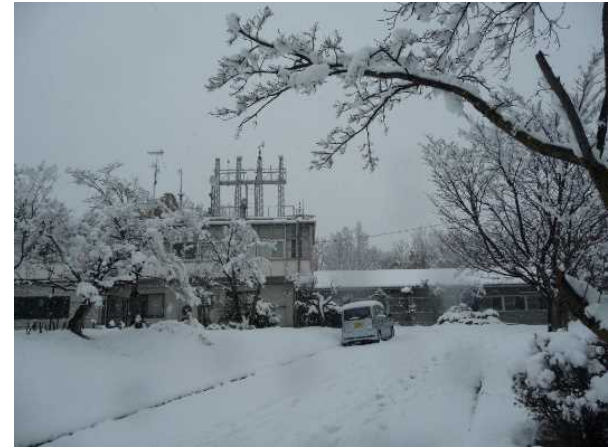
奈良地方気象台(奈良県奈良市)の積雪の状況 14日12時頃 撮影：奈良地方気象台職員 (奈良地方気象台は、平成29年3月9日に奈良市半田開町から奈良市西紀寺町に移転。この移設に伴う統計の切断はなし)
