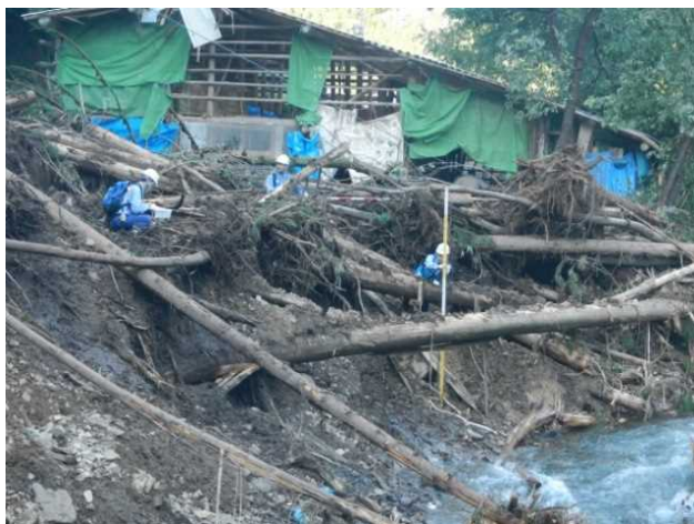
提供：国土交通省近畿地方整備局 兵庫県粟市波賀町道谷
