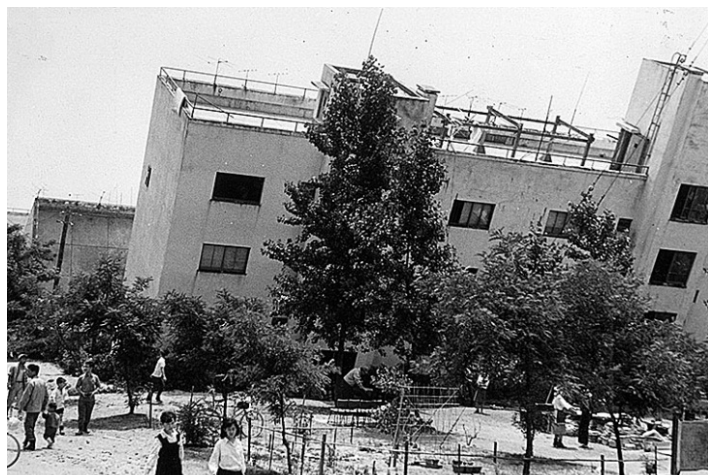
写真 液状化による被害例(防災科学技術研究所HPより)
