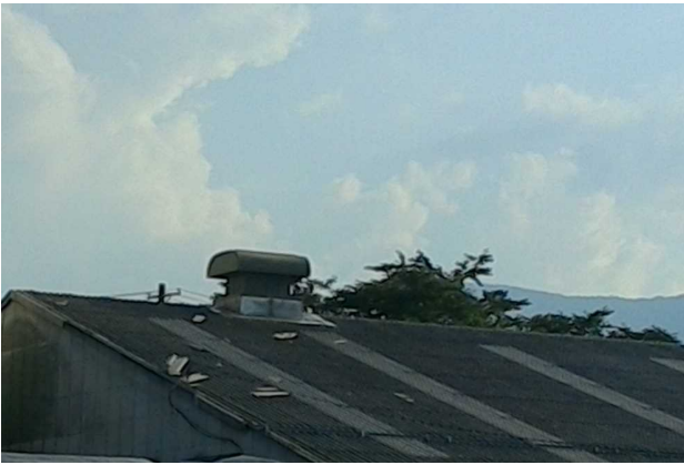
① スレート屋根が破損した鉄骨造倉庫 (北方向から撮影)
