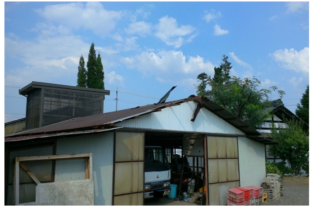
④ トタン屋根がめくれた倉庫 (南方向から撮影)
