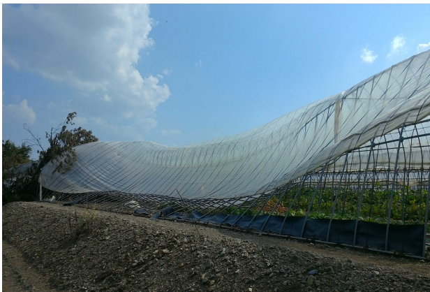
③ 鋼管が変形したパイプハウス (北方向から撮影)
