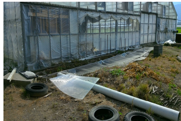
⑥ 被覆材がはく離したパイプハウス (南方向から撮影)
