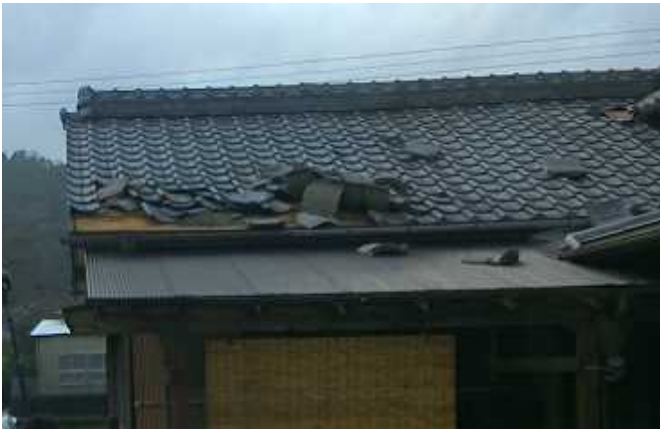
①屋根瓦がめくれた住家
