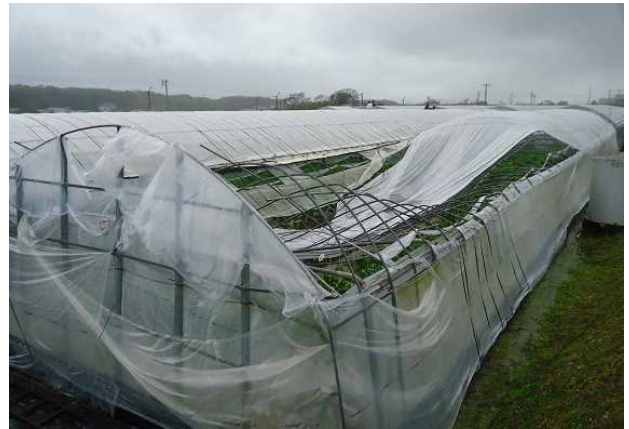
②鋼管が変形したパイプハウス
