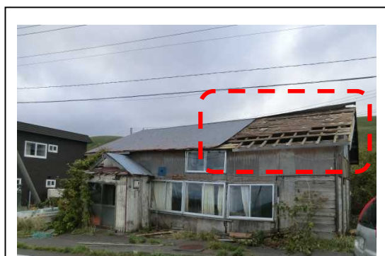
③ 木造倉庫の屋根ふき材のはく離 屋根の北側がはく離
