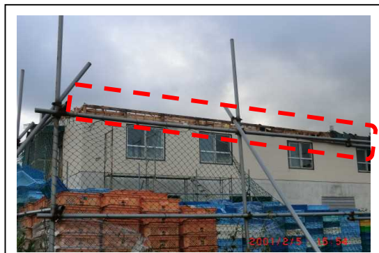
① 木造倉庫の屋根ふき材のはく離 屋根の北側の軒から上側へはく離
