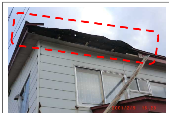
② 木造民家の屋根ふき材のはく離 北側の屋根が軒から浮き上がり
