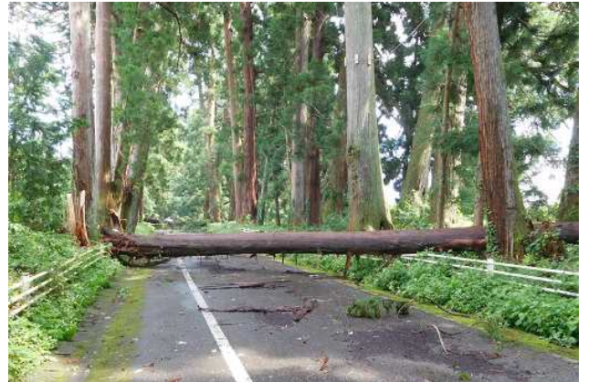
④ 幹折れした杉 (北西方向から撮影)
