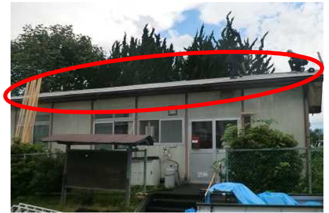
② トタン屋根が飛散した非住家 (北東方向から撮影)
