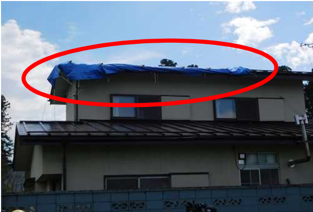
③ トタン屋根がめくれた住家 (北東方向から撮影)
