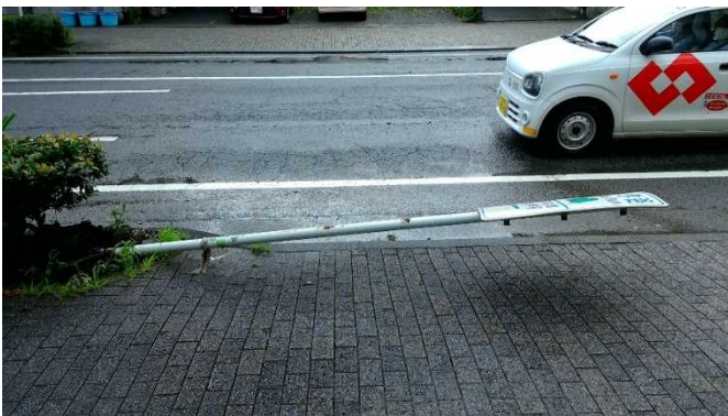
⑤ 倒れた標識 (東方向から撮影)
