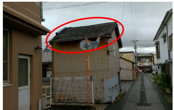
⑥ トタン屋根がめくれた非住家 (南方向から撮影)
