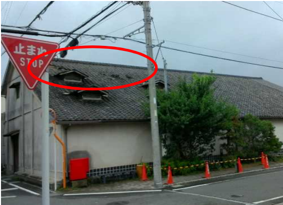
① 屋根瓦がめくれた住家 (南東方向から撮影)
