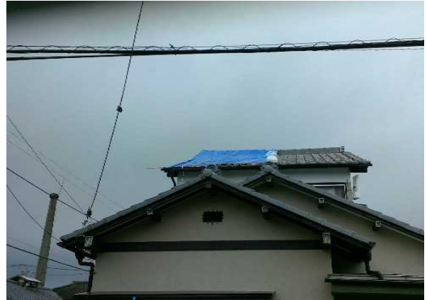
② 屋根瓦がめくれた住家 (南方向から撮影)
