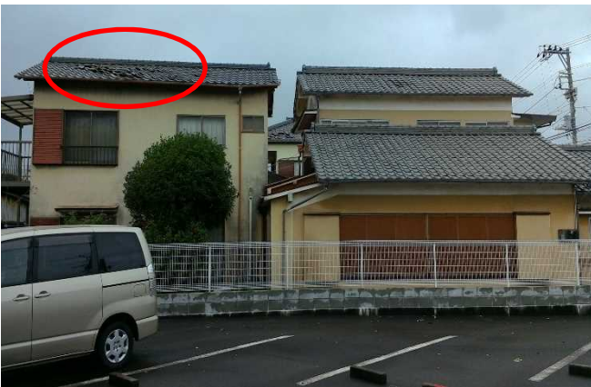
③ 屋根瓦がめくれた住家 (東方向から撮影)
