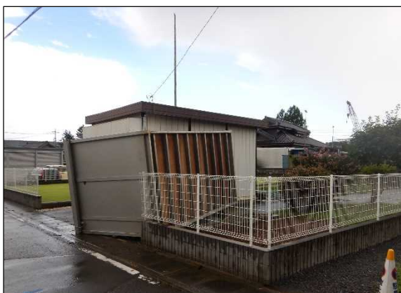
⑥横転した物置 (北西方向から撮影)
