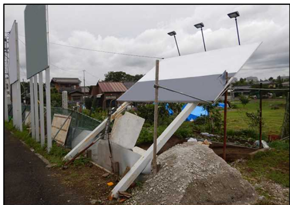
⑤支柱が傾斜した広告板 (南東方向から撮影)
