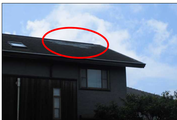
③屋根のトタンがめくれた住家 (北西方向から撮影) (三郷市危機管理防災課提供)
