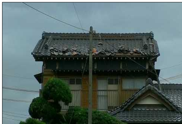
①屋根瓦がめくれた住家 (南東方向から撮影)
