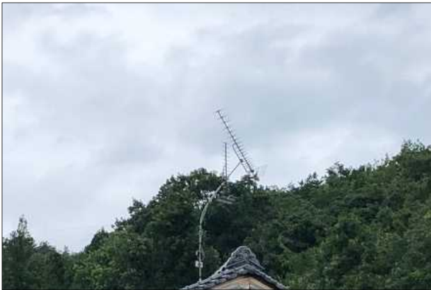
① 支柱が傾斜したアンテナ (南方向から撮影：八百津町提供)
