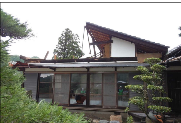
⑤ 小屋組みが飛散した住宅 (南方向から撮影)
