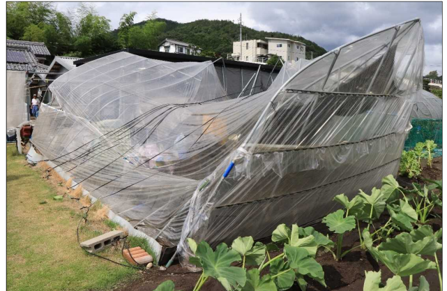
② 鋼管が変形したパイプハウス (南方向から撮影：八百津町提供)
