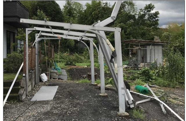
④ 屋根部分が飛散したカーポート (西方向から撮影：八百津町提供)
