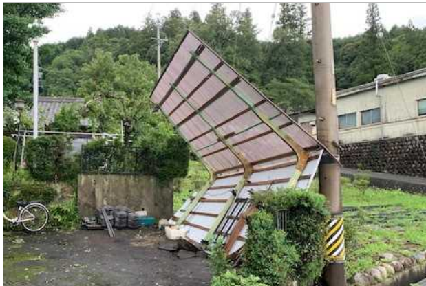
③ 骨組みが傾斜したカーポート (南方向から撮影：八百津町提供)
