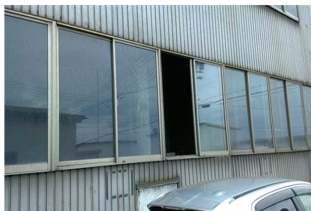
④ 割れた窓ガラス (南東方向から撮影)
