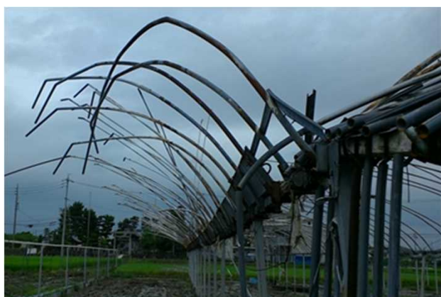
③ 錆びた骨組みが壊れたパイプハウス (南方向から撮影)
