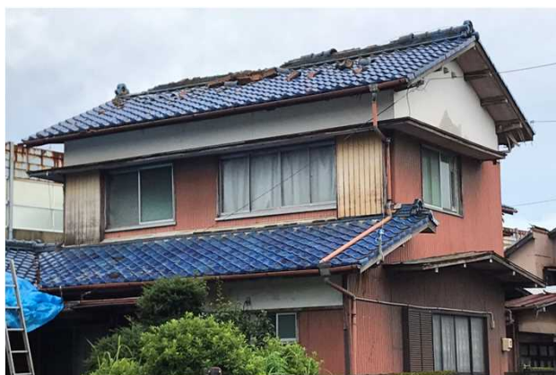
① 屋根瓦がめくれた住家 (北東方向から撮影)
