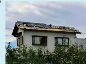
突風被害例 (住家の屋根瓦の飛散)
