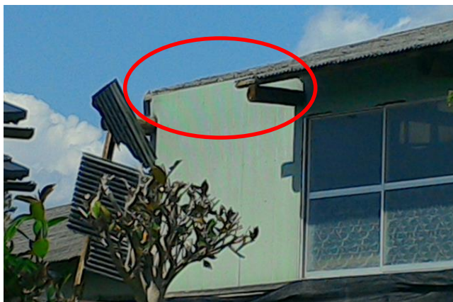
① といが一部破損した牛舎 (南西から撮影)
