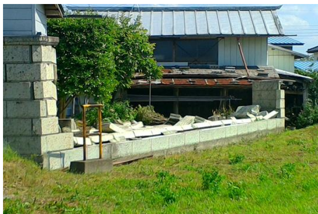
② 倒壊した石塀 (北西から撮影)
