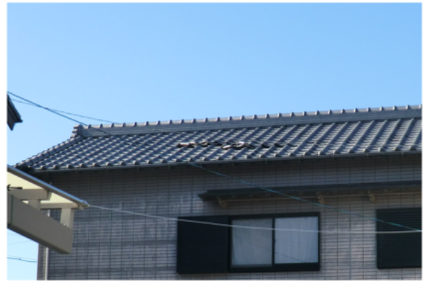
② 屋根瓦がはく離した住家 (東方向から撮影)
