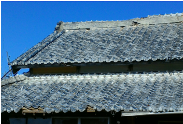
① 棟瓦と軒先瓦が破損した住家 (南方向から撮影)
