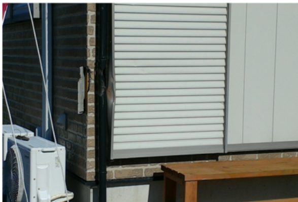
③ 一部損壊した住家の壁と戸 (南西方向から撮影)
