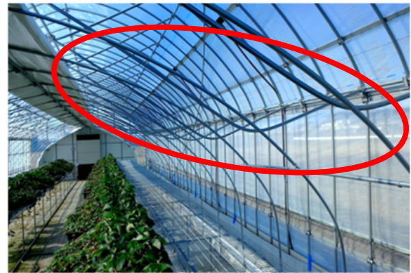
④ 鋼管が変形したパイプハウス* (東方向から撮影)
