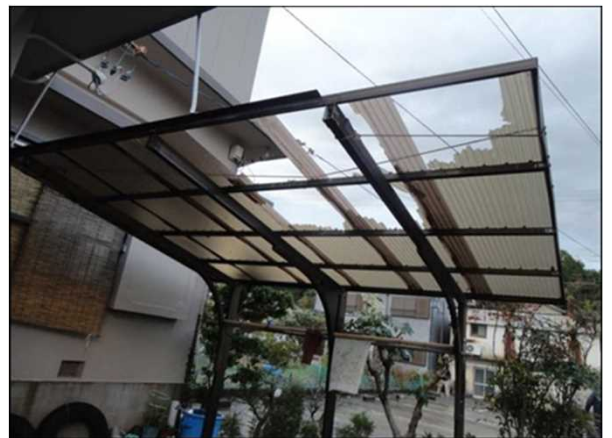
② 屋根パネルが破損したカーポート (西方向から撮影)
