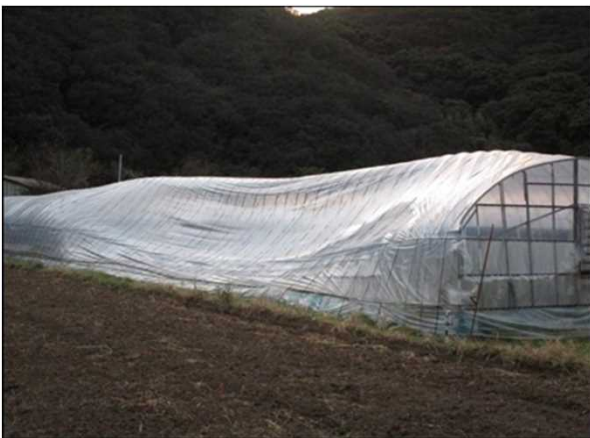
① 鋼管が変形した農業用ハウス (北方向から撮影)
