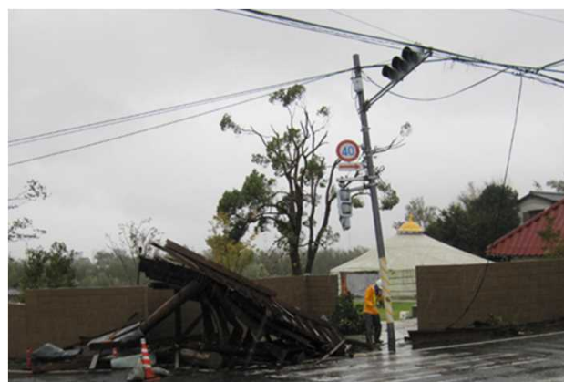
⑥ ゆるんだ電線と消灯した信号 (東方向から撮影)
