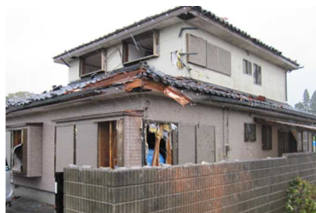
⑤ 屋根瓦が飛散し、 窓ガラスが破損した住家 (北東方向から撮影)
