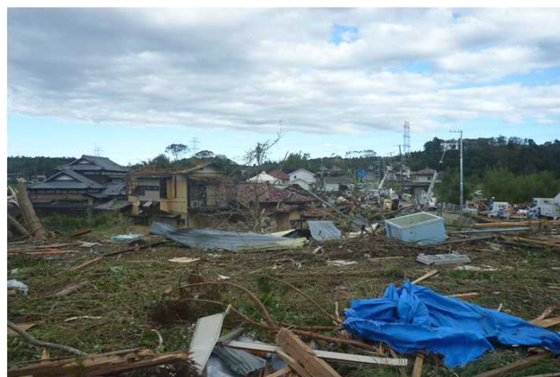
③ 数多くの家屋に被害のあった地域 (西方向から撮影)
