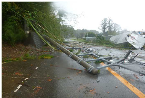
④ 倒壊した電柱 (東方向から撮影)
