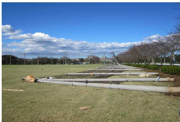
① 倒壊したネットの支柱 (南方向から撮影)
