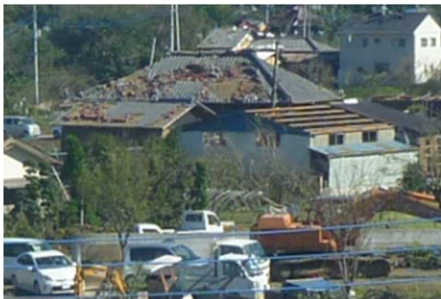
② 屋根瓦が飛散した住家 (西方向から撮影)
