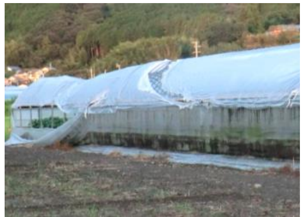
写真④ 鋼管(直径25mm)が変形した パイプハウス(南西方向から撮影)
