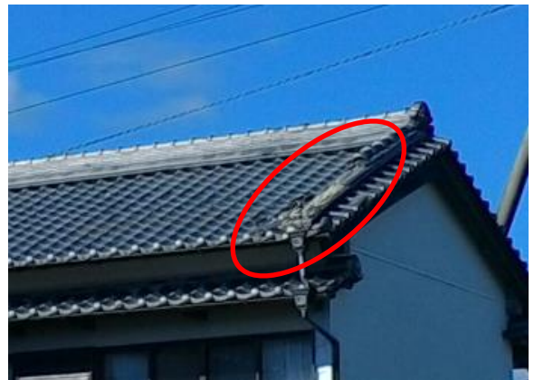
写真② 屋根瓦が飛散した住家 (南方向から撮影)
