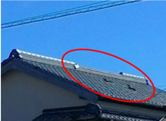
写真① 屋根瓦が飛散した住家 (北西方向から撮影)
