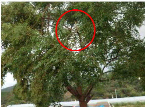
写真③ 枝折した樹木 (西方向から撮影)
