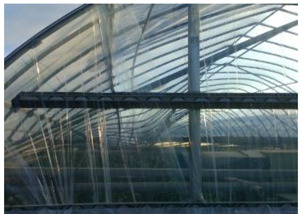
写真⑥ 鋼管(直径25mm)が変形した パイプハウス(北東方向から撮影)
