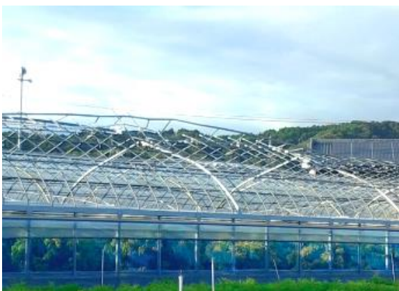
写真⑤ 鋼管(直径25mm)が変形した パイプハウス(南方向から撮影)
