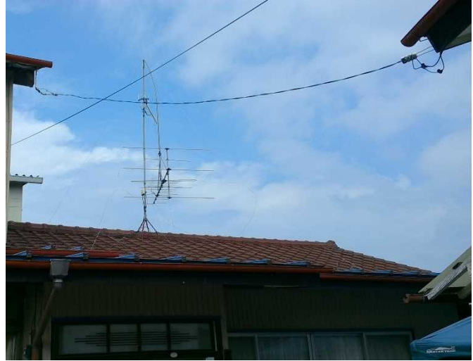
② 南方向へ折損したアンテナ (南方向から撮影)
