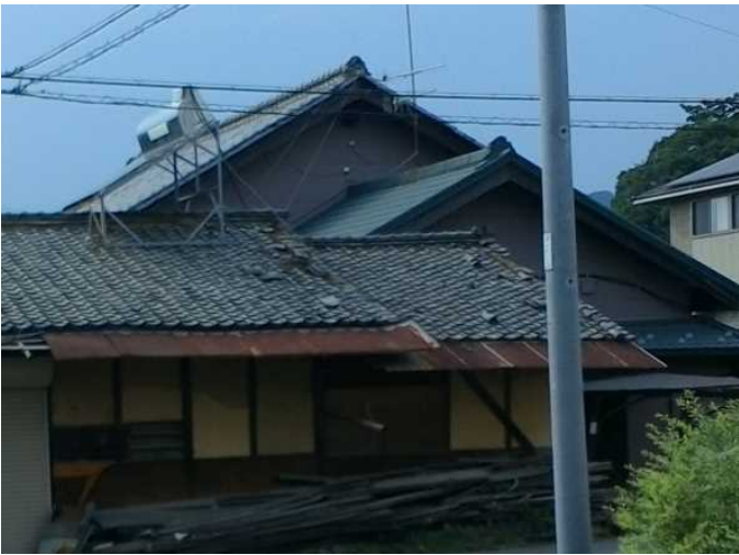
③ 屋根瓦がめくれた住家 (東方向から撮影)
