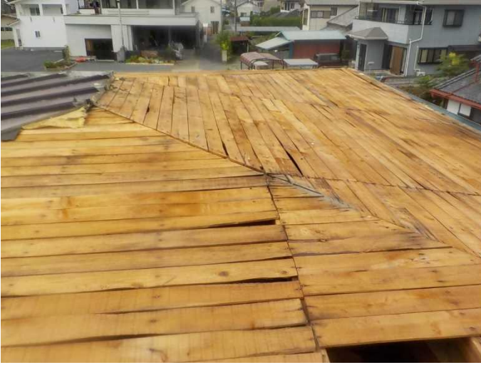
① トタン屋根の飛散した住家 (東方向から撮影)
