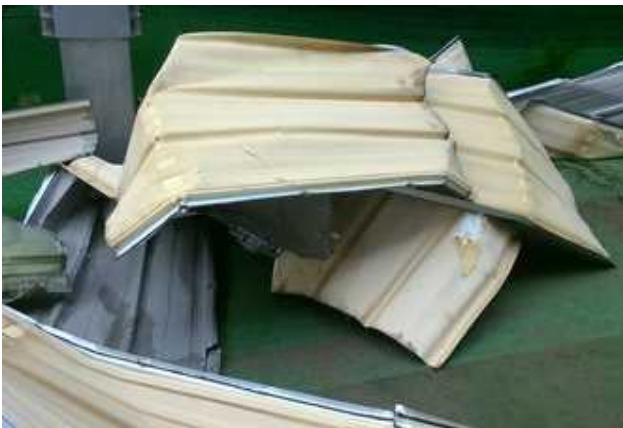
③ めくれたテニスコートの屋根材 (西南西方向から撮影)
