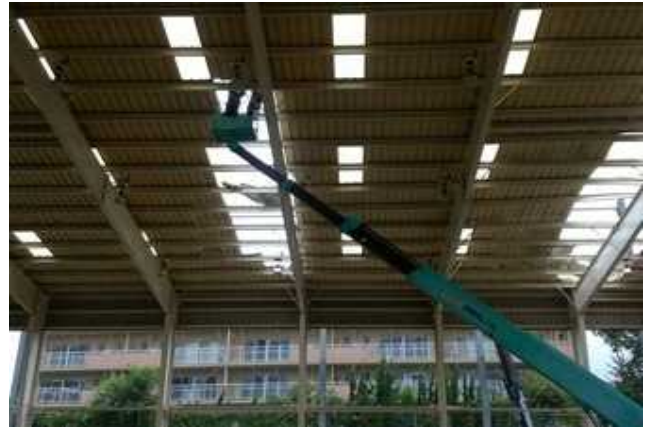
② 屋根がめくれたテニスコート (南南東方向から撮影)
