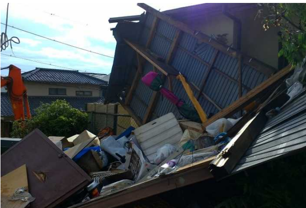
① 倒壊した物置 （東方向から撮影）
