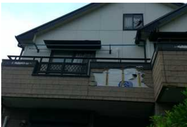
⑤ 飛散物により壁が剥がれた住宅 (南東方向から撮影)
