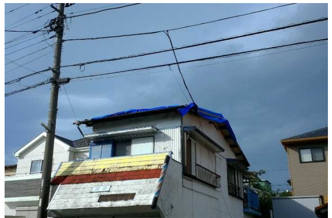
② トタン屋根のめくれた理容店 （南東方向から撮影）
