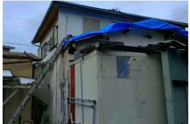
② 屋根が破損した住宅兼店舗 (南方向から撮影)
