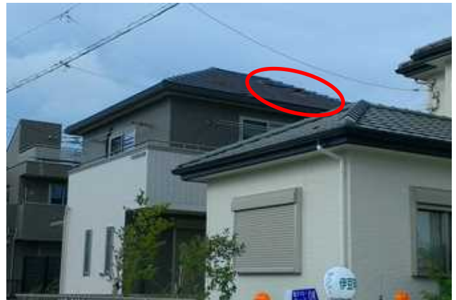
④ 屋根瓦のめくれた住宅 (南西方向から撮影)
