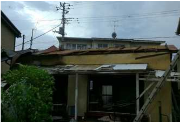
① トタン屋根が飛んだ住宅 (南方向から撮影)
