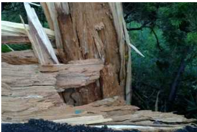
⑤ 幹折れした桜 (北西方向から撮影)
