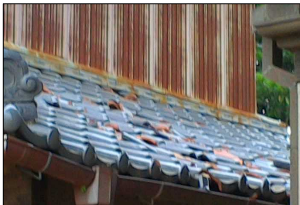
② 飛散した屋根瓦 (北西方向から撮影)
