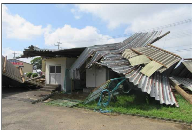
③ 倒壊した倉庫 (北東方向から撮影)
