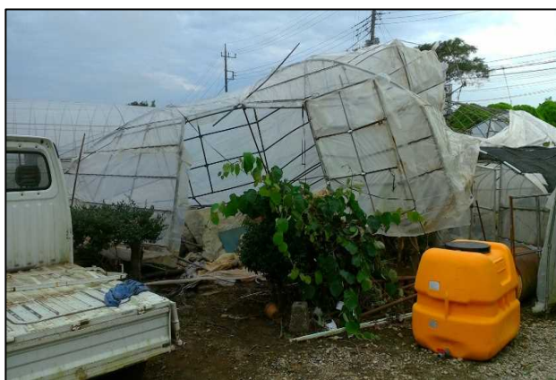
③ 変形したパイプハウス (北西方向から撮影)
