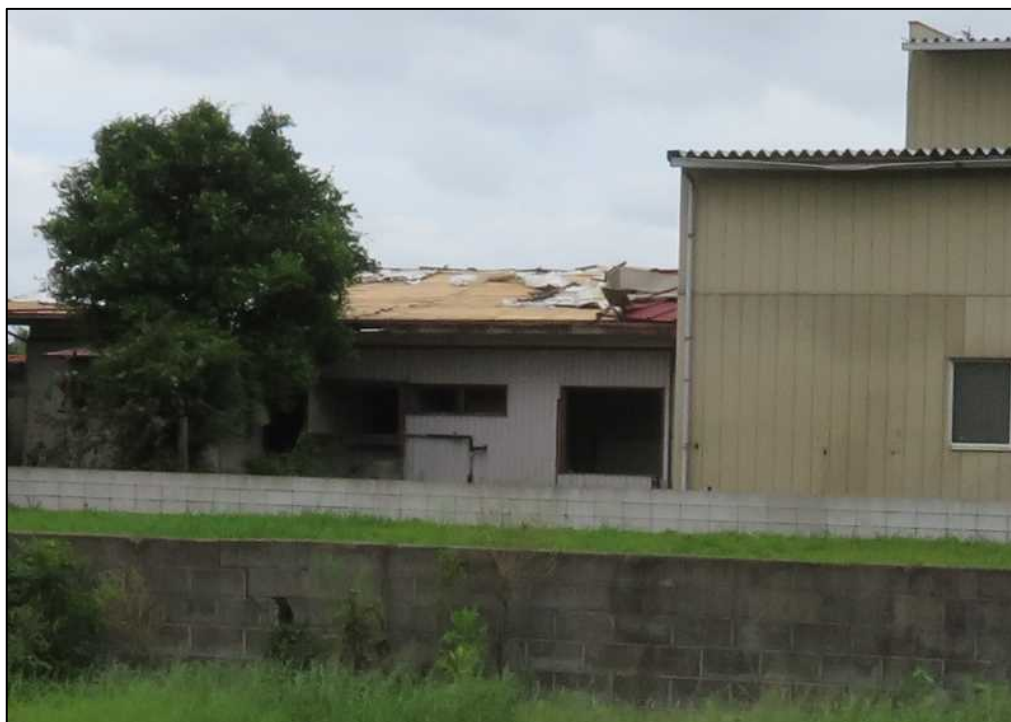
① トタンのめくれた屋根 提供：銚田市役所 (西方向から撮影)
