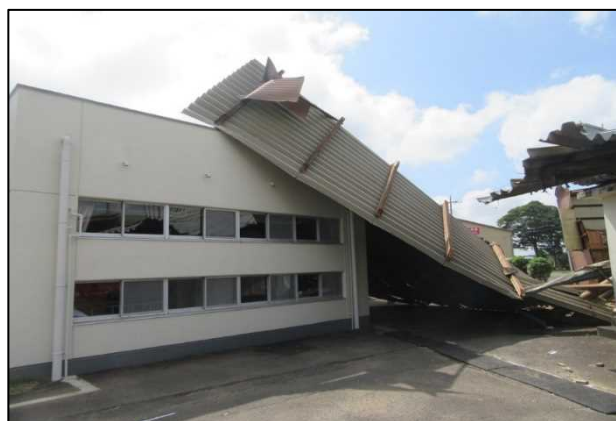
② 倒壊した倉庫から飛散した屋根 (北方向から撮影)
