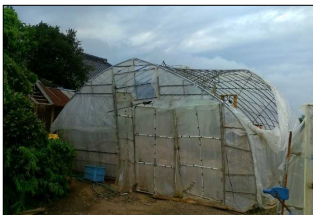
④ 変形したパイプハウス (南東方向から撮影)
