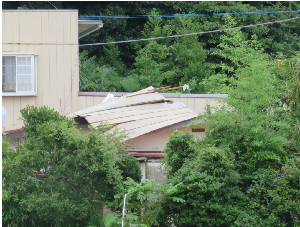
② トタンのめくれた屋根 提供：銚田市役所 (北東方向から撮影)
