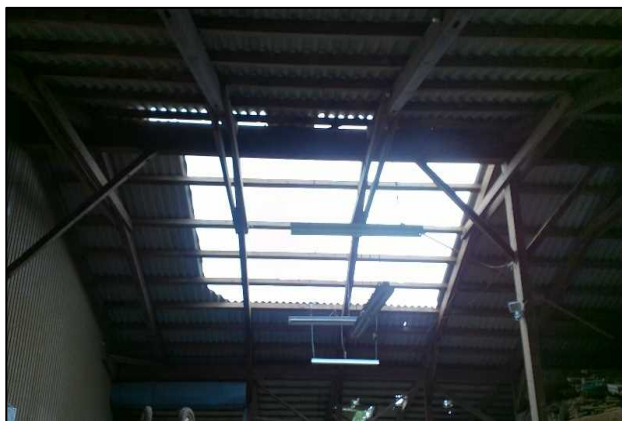
① 屋根ふき材がはく離した農業用倉庫 (倉庫の内部にて南東方向から撮影)
