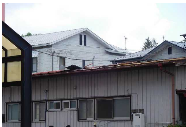
② トタン屋根の一部がめくれ、飛散した住家 全景（北西から撮影）
