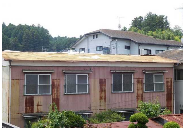
① トタン屋根が飛散した住家 全景（北東から撮影）
