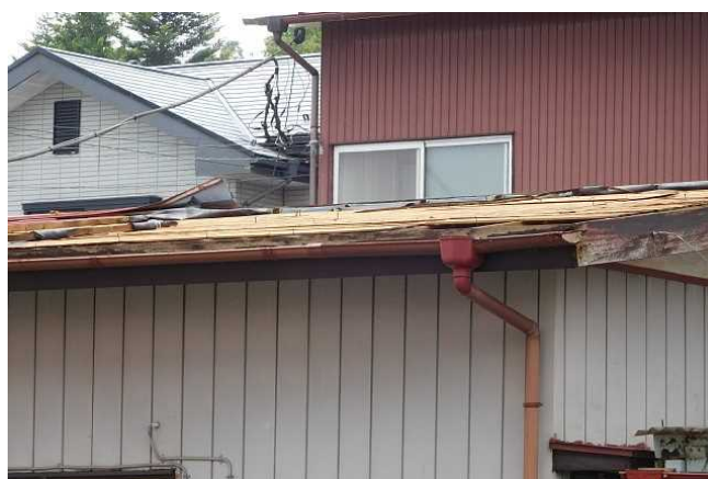
② トタン屋根の一部がめくれ、飛散した住家 拡大（北西から撮影）
