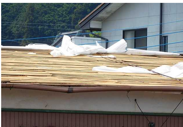
① トタン屋根が飛散した住家 拡大（北東から撮影）
