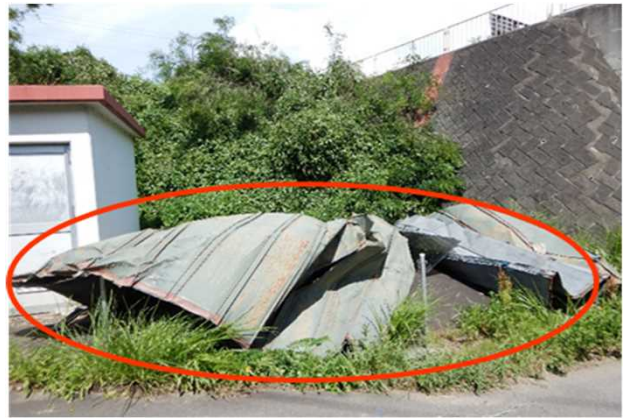
② めくれて飛んだトタン屋根※ (南西方向から撮影)
