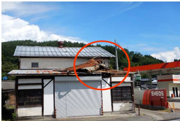
③ トタン屋根がめくれた倉庫 (南西方向から撮影)
