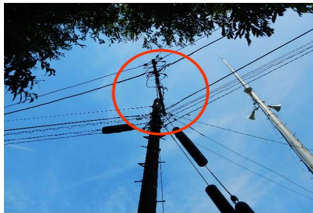
② 折れた枝が架線に掛かり、 上部が折損した電柱 (南東方向から撮影)
