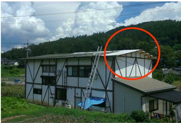
① トタン屋根がめくれた事業所 (南西方向から撮影)
