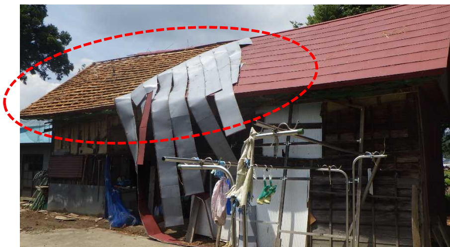
③ 木造非住家の屋根ふき材（金属板ふき）のはく離（北東方向から撮影）
