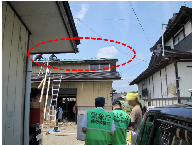
① 木造非住家の屋根ふき材（金属板ふき）のはく離（南方向から撮影）
